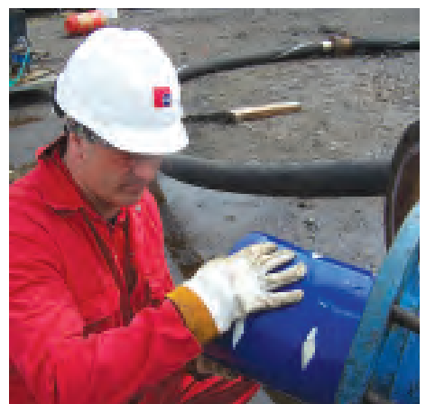
Пенополиуретановый снаряд загружается в трубопровод
